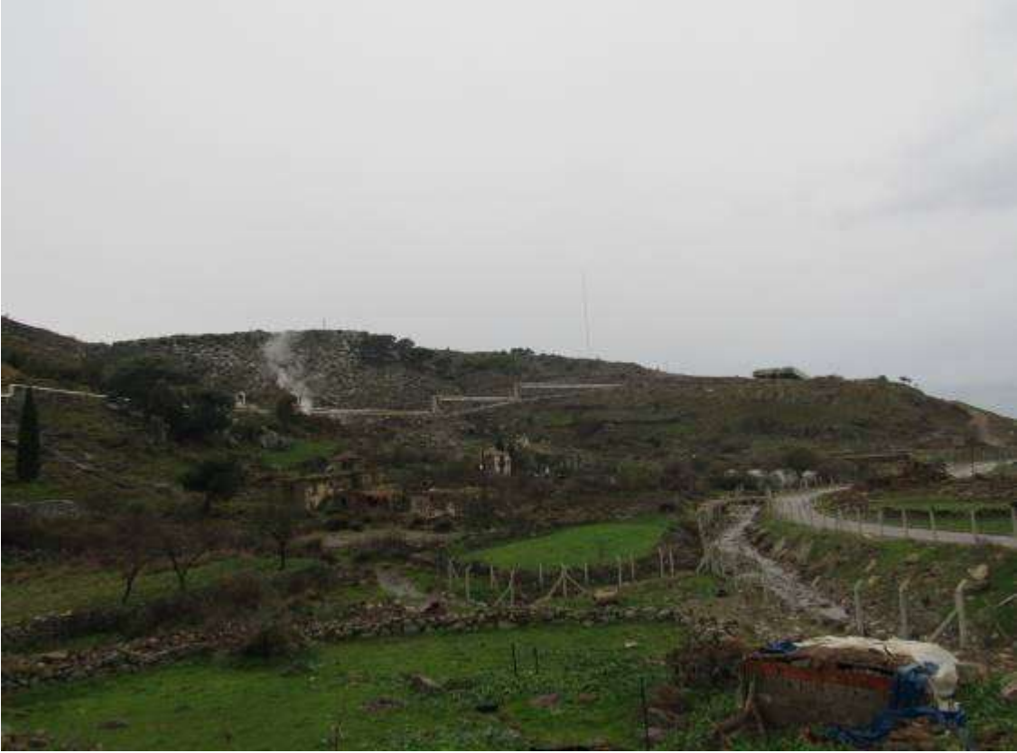
Tesisin Görünümleri Türbin ve Jeneratör Üniteleri
