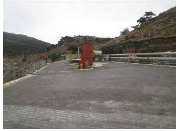
Boru Hattı ve Re-Enjeksiyon Pompası 1
