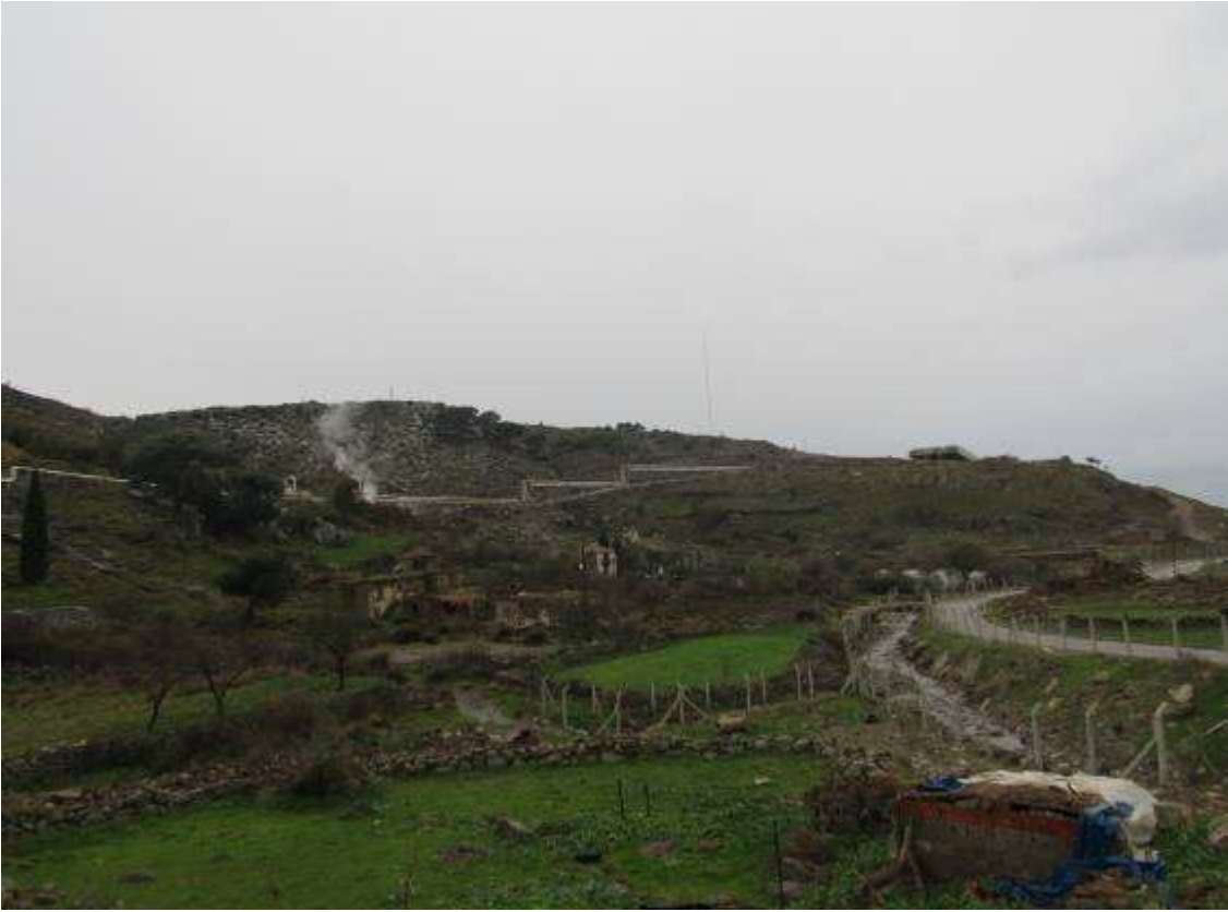
Tesisin Görünümleri Türbin ve Jeneratör Üniteleri
